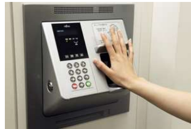
執務室入室時
